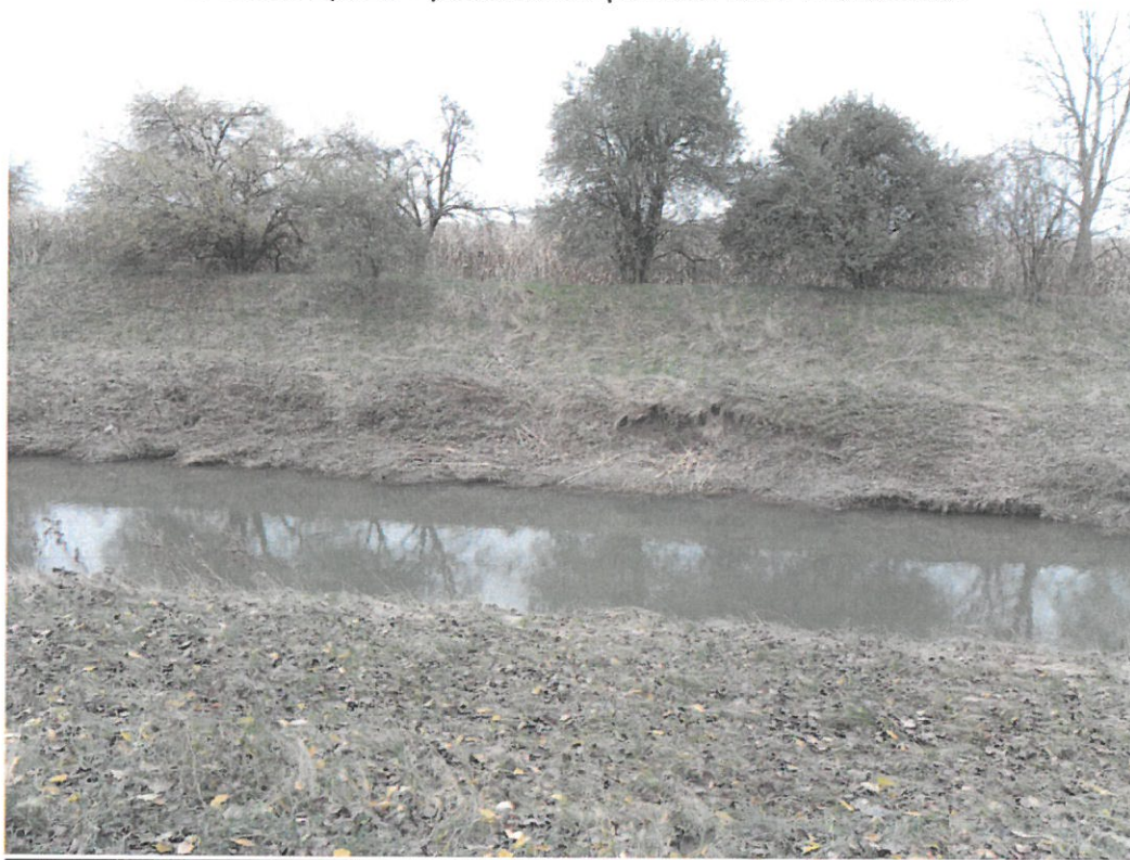
Břehové výtrže + poškozené opevnění kam. rovnáninou
