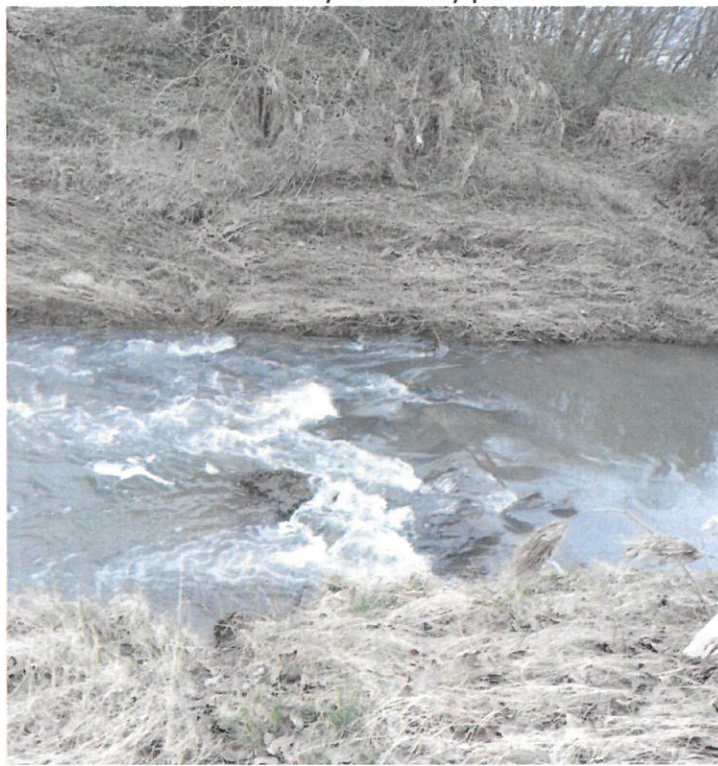
Poškozený kamenný práh
